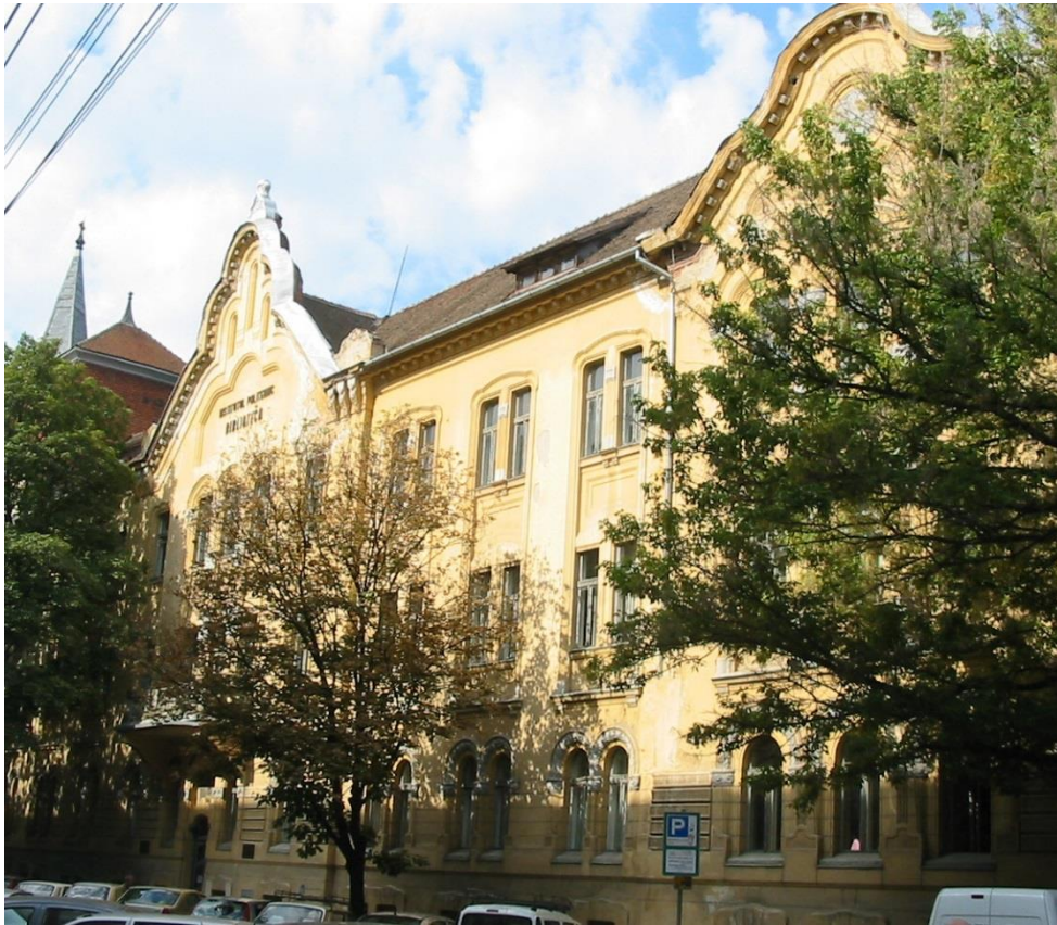
Figura 4. Clădirea din strada Piatra Craiului, nr. 2, primul sediu al laboratoarelor de Materiale de construcții
